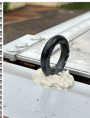
吊りボルトの防水コーキング 横扉を南京錠で施錠出来る様にプレート取り付け改造
