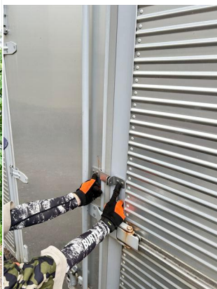
吊りボルトの防水コーキング 横扉を南京錠で施錠出来る様にプレート取り付け改造
