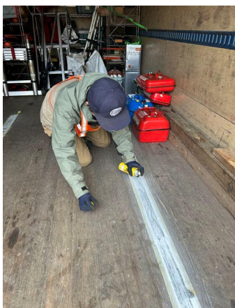
運搬車収納ライン吹きつけ
