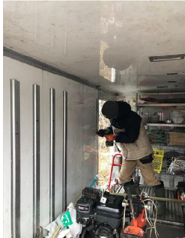
縦の凸部取付穴あけ中
