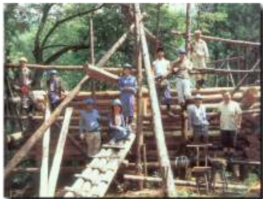
初期ログハウスの途中の様子。壁積上げの後期
