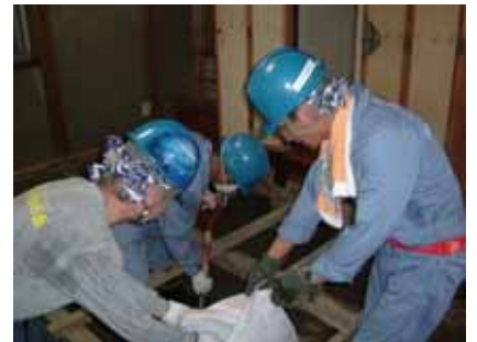
床下の泥だし作業。3～4人で1部屋の片付けが1日かかり。
