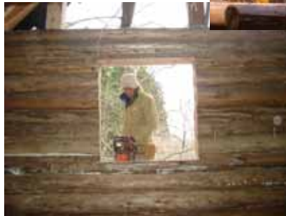
窓開口を切り込む 長年積み上げてきたログに 開口を切り込む
