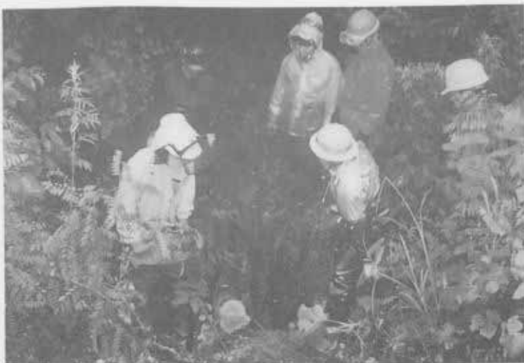
① 現場に通じる道の、台風で増水した沢に仮橋を架ける
