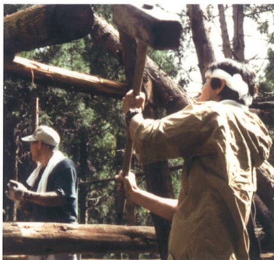
↑ 掛矢を振るって丸太を所定の位置に押し込むのは簡単そうで面倒である
