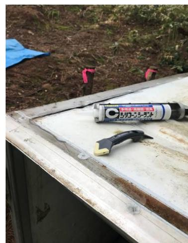
コンテナの雨漏り補修
