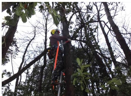
安全帯で確保しつつ、道路側への倒れ止めスリングと、ロープウィンチャーのロープを取り付ける
