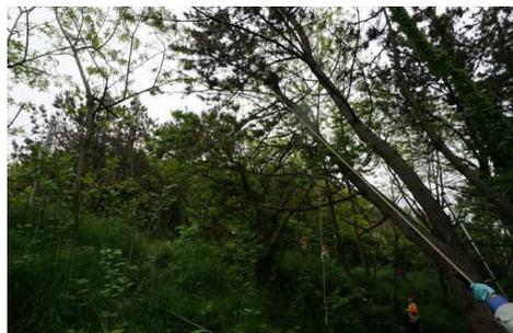
幹の途中に滑車をかけて、先端の長さを短縮し、道路へはみ出る危険を軽減
