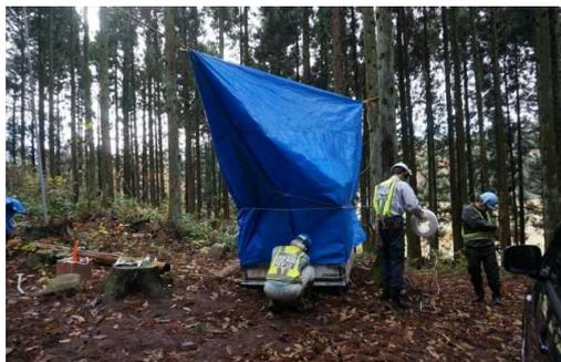
2本の樹間にトラロープを渡し、ブルーシートで三角屋根をつくり、隙間を閉じて保管庫に縛り付けた。来春まで持ってくれる事に期待。
